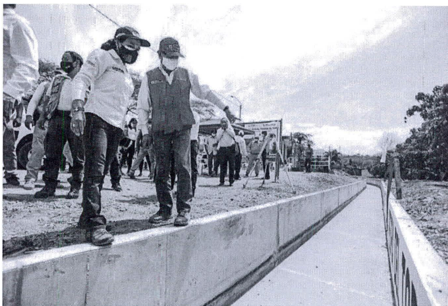
Ministro de Trabajo inspeccionando uno de los canales provisionales de la Represa Tapa de Cuy. Construida exclusivamente por los comuneros.
