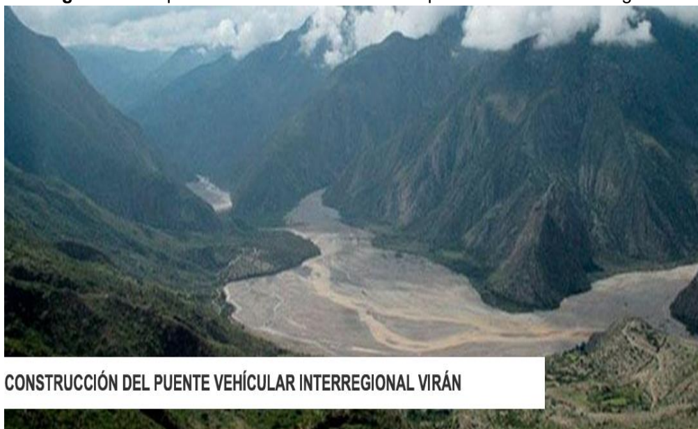
Imagen 1. Vista panorámica de la ubicación del puente vehicular interregional Virán
