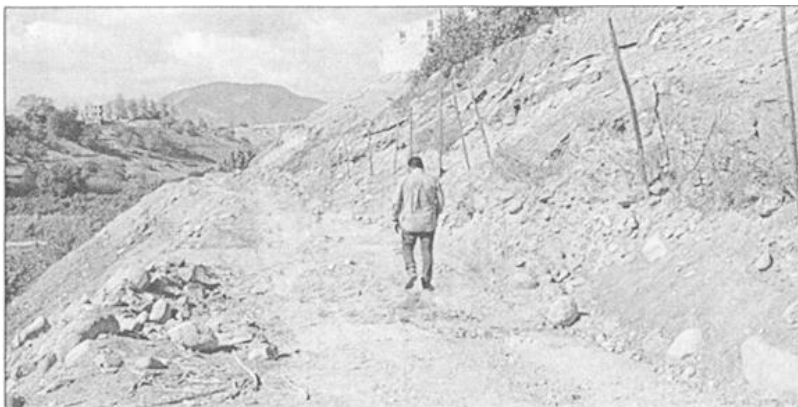
Imagen 04. Tramo Vía Sector
