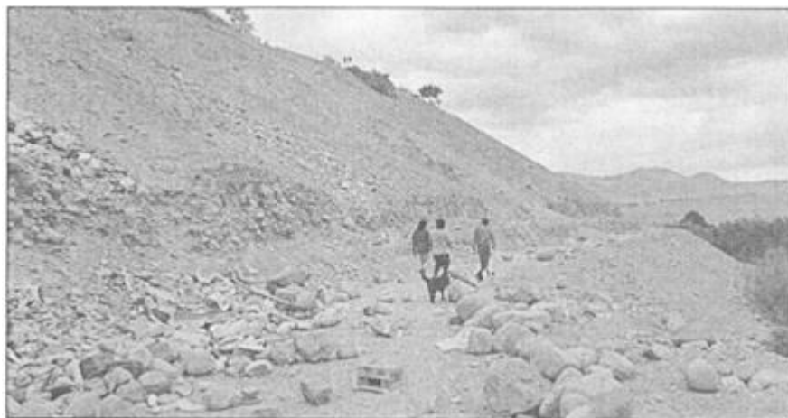
Imagen 06. Tramo de Vía Sector 14-2
