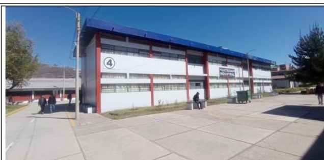
PABELLON DE ELECTRICIDAD INDUSTRIAL
