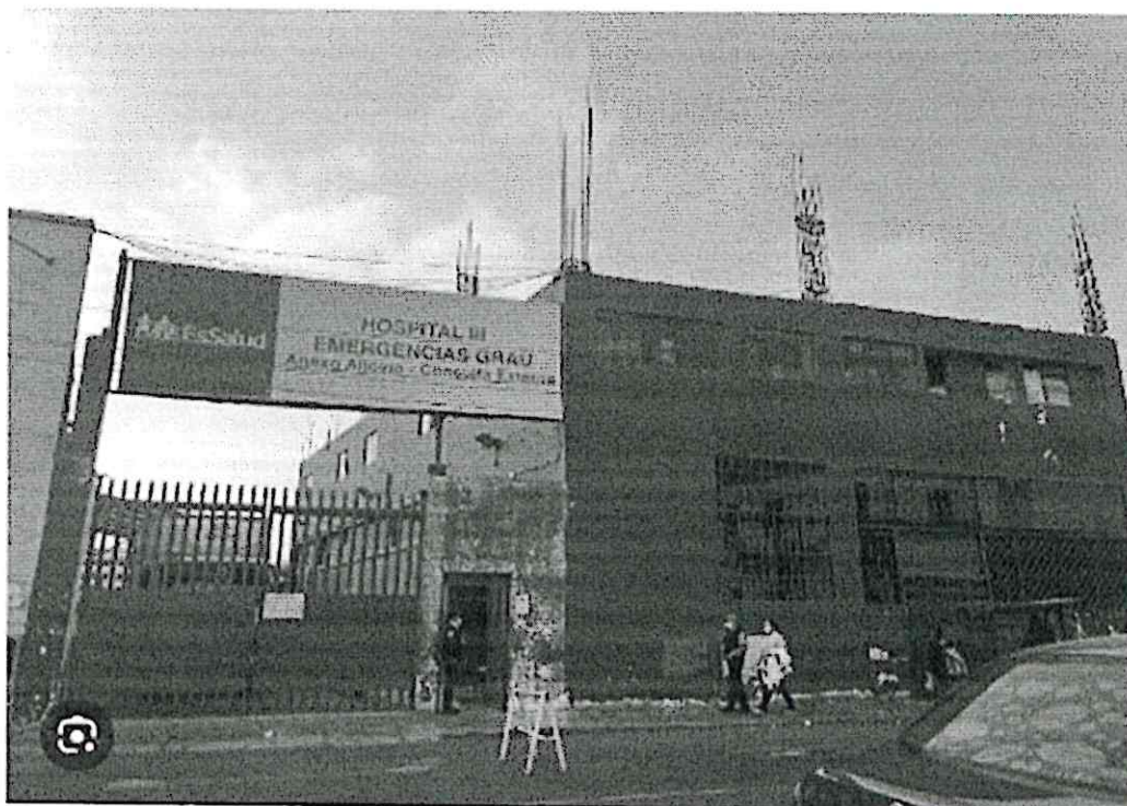
Fotografía N° 03: Hospital III Emergencias Grau – Anexo Aljovín
