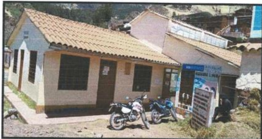
FIGURA 4: Puesto de Salud de Qarhuapampa
