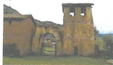
Vista posterior de la fachada de acceso
