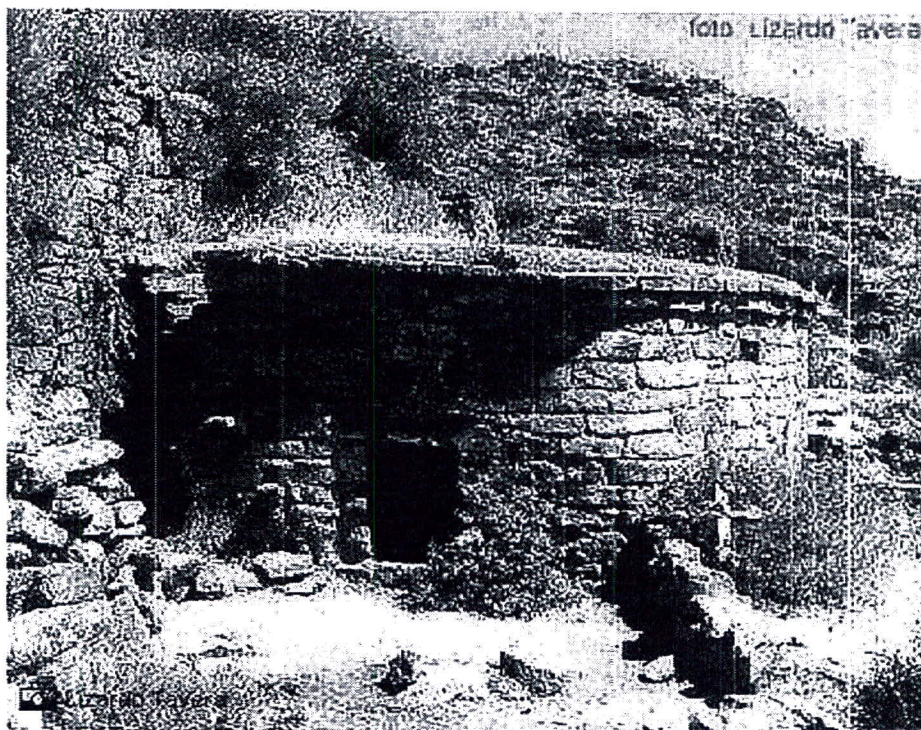
Una de las estructuras mejor conservadas en Cantamarca. Se conserva su techo original. Altura total: aproximadamente 2.50 metros.
