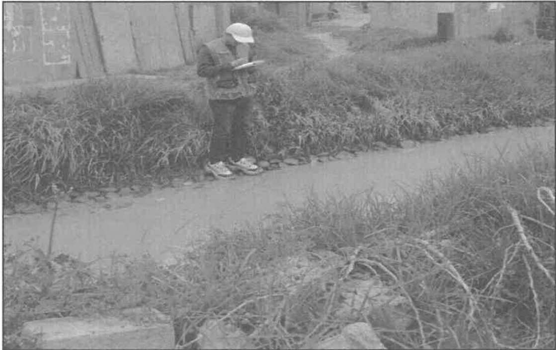
Fotografía 1: Inundación detectada por inexistencia de sistema de drenaje en la Avenida 9 de Octubre con Pasaje Nuñez (2024)
