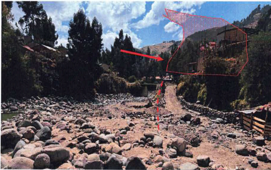
FIGURA N°02: DE ACUERDO A LA MANIFESTACION DE LAS AUTORIDADES EL CAUDAL DEL RIO EN TEMPORADAS DE LLUVIAS AUMENTA AFECTANDO LAS VIVIENDAS.
