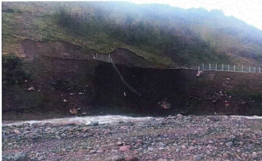
FIGURA N°02: DE ACUERDO A LA MANIFESTACION DE LAS AUTORIDADES EL CAUDAL DEL RIO EN TEMPORADAS DE LLUVIAS AUMENTA AFECTANDO LAS CARRETERA.
