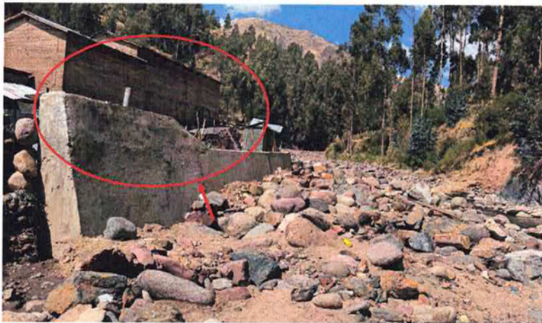
FIGURA N°05: LAS VIVIENDAS Y LAS PERSONAS QUIENES HABITAN EN LA MARGEN DEL RIO SE ENCUENTRAN EXPUESTA ANTE UN PELIGRO DE INUNDACION.
