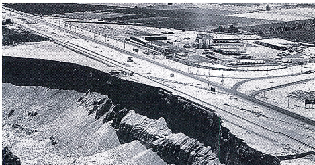
Deslizamientos cerca al kilómetro 930 de la carretera Panamericana Sur, frente a la planta de recepción de leche del Grupo Gloria, en 2015.
