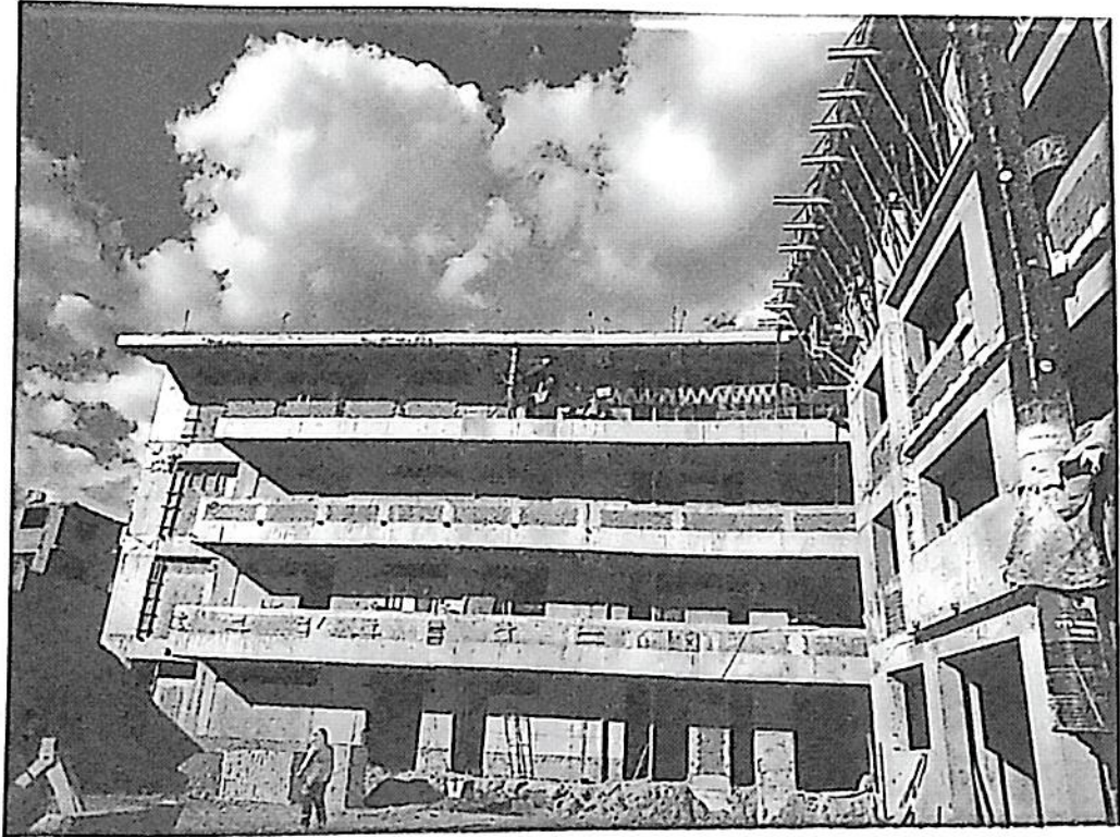
Fotografía N°05: Vista panorámica de los bloques-4 y 5
