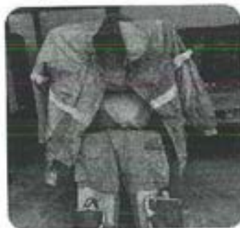
Equipos deteriorados y vehíc...
