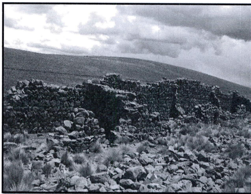
Figura 21 Vivienda de los Salcedo destruida Fuente: Pilco (2020)
