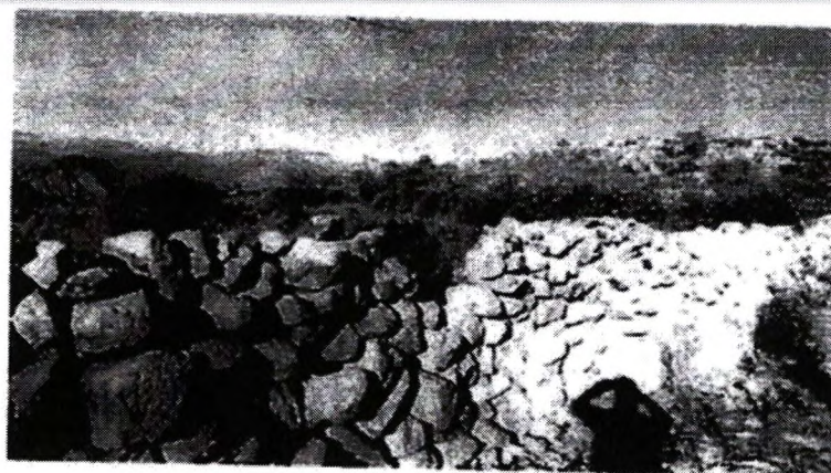
Han tumbado esta pirca para el paso de la yunta y vuelto a pircarlo (camino principal)
