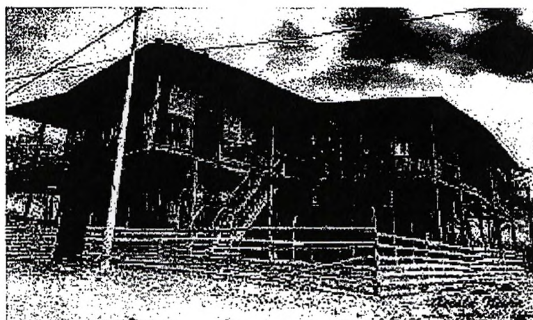
Vista de la Casa Hacienda El Limón
